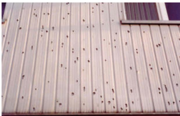
Figure 3: Dégâts de grêle sur une façade en matière synthétique à Wetzikon, en 2004. (Source: Thomas Egli)
