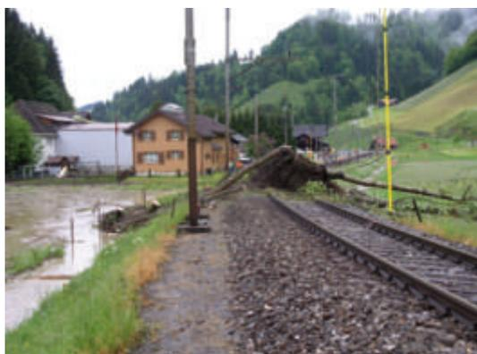
Figure 6: Arbre tombé sur la ligne de contact à Wiggen. (Photo: CFF)
