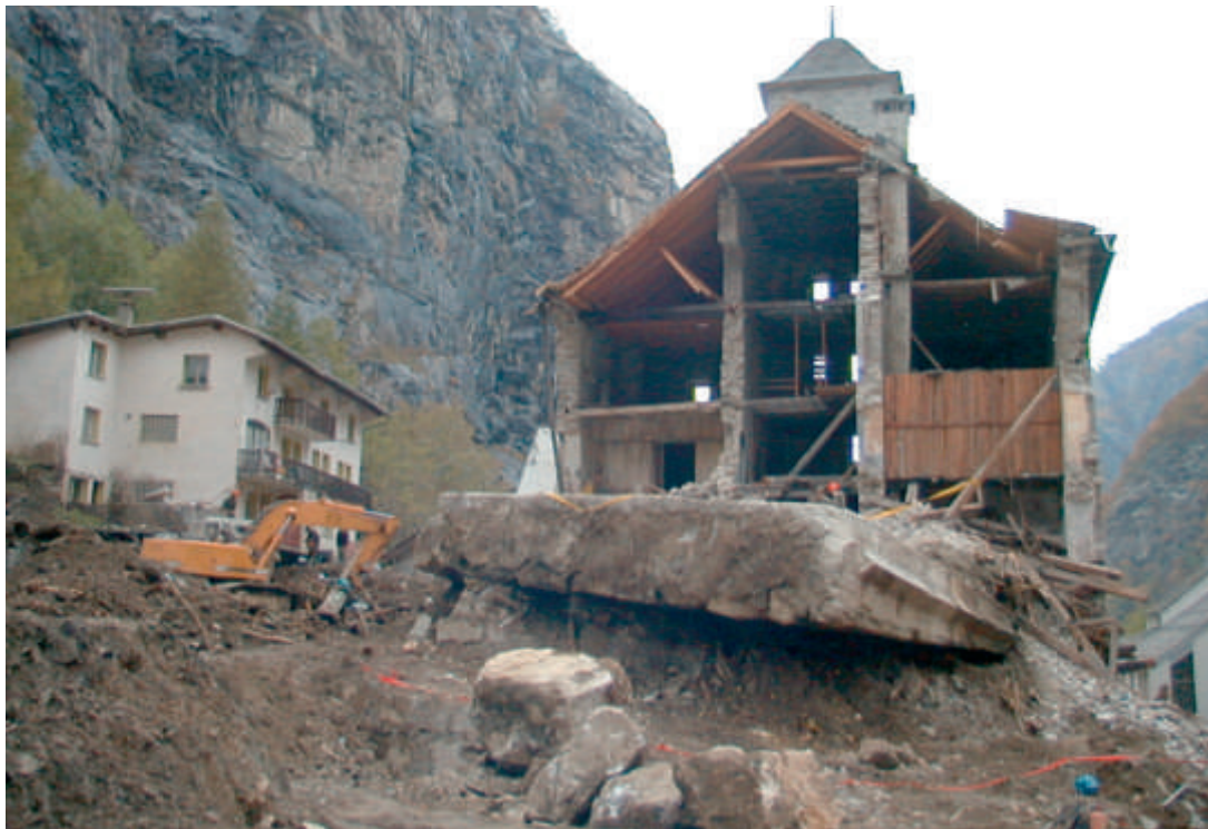
Figure 2: Lave torrentielle à Gondo, VS, en automne 2000, après de violentes précipitations. (Source: Association des établissements cantonaux d'assurance incendie, Commission Eléments naturels. AEAI, Berne)
