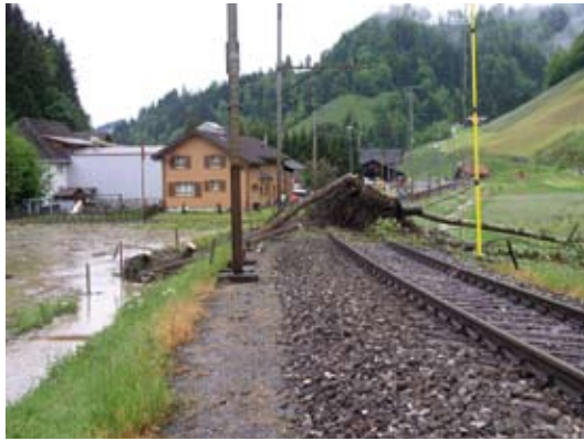
Abbildung 6: Baum auf Fahrbahn, Wiggen (Bild: SBB)
