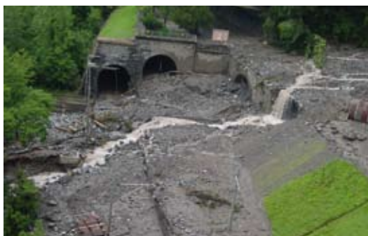
Abbildung 5: Hochwasser August 2005, Dornibach/SZ (Quelle: SBB)
